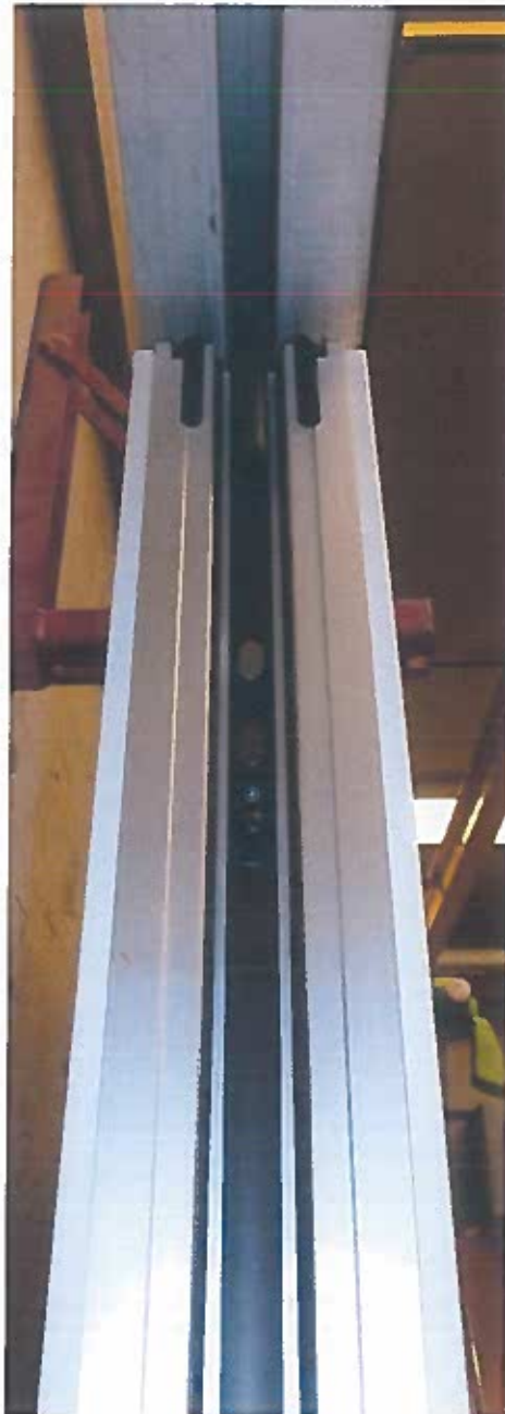
Bild 4 Detailansicht: Trennwandelement Sporthallentrennwandsystem "NW Premium EASYmatic"
